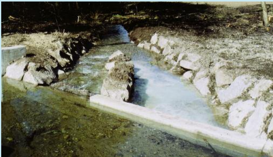
Fische können im neu gestalteten Petribach Stufen mittels Fischtreppen überwinden.
