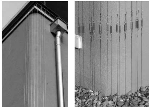
Abb. 3: Abwehrdrähte in spechtgefährdeten Fassadenbereichen und Detailaufnahme mit Spannelementen (Fotos V. Döbelin).
