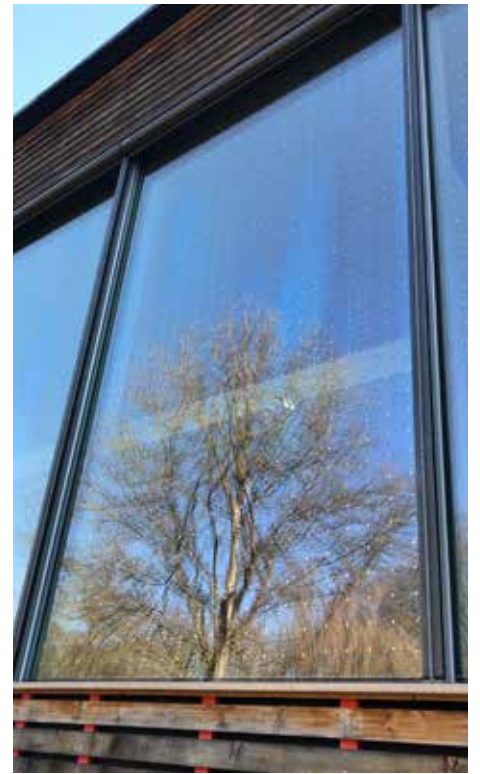
Eine neuartige Lösung sind sogenannte «SEEN Elements». Die hochreflektierenden Punkte reduzieren das Kollisionsrisiko deutlich und ermöglichen gleichzeitig eine gute Sicht. © Rouven Seidler
