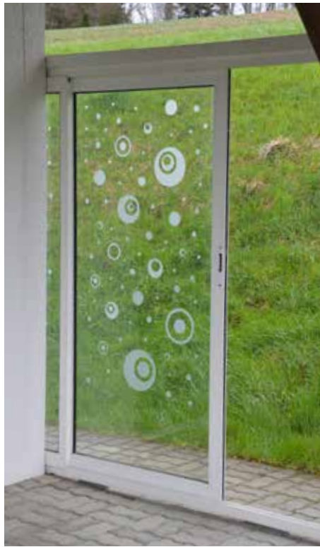
Motive aus Kristallfolie bieten – wenn relativ dicht aufgebracht – recht guten Schutz. Sie sind an sich in beliebigen Formen produzierbar. © ZVG
