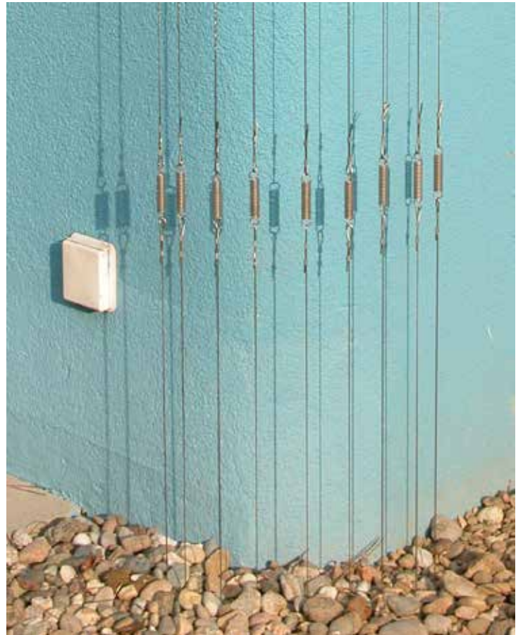
Abwehrdrähte in spechtgefährdeten Fassadenbereichen und Detailaufnahme mit Spannelementen. © Verena Döbelin.
