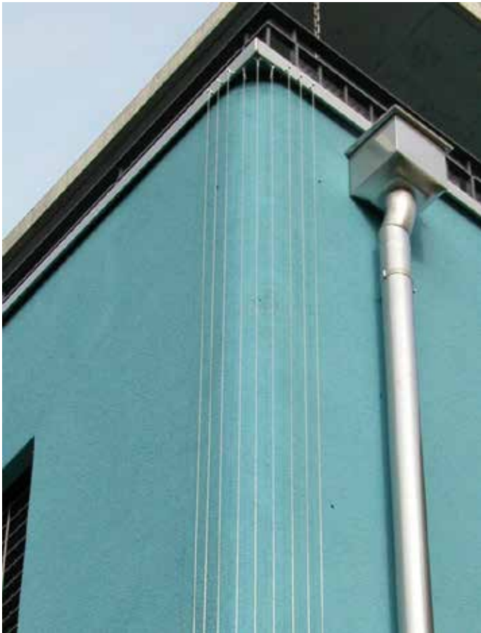
Abwehrdrähte in spechtgefährdeten Fassadenbereichen und Detailaufnahme mit Spannelementen. © Verena Döbelin.
