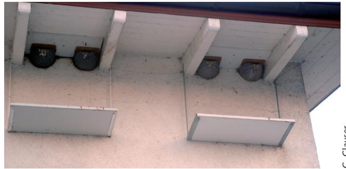
Fig. 14: per la protezione della facciata, delle tavolette per gli escrementi sono fissate possibilmente con staffe metalliche. Dello spazio tra le tavolette permette di appoggiare la scala.
