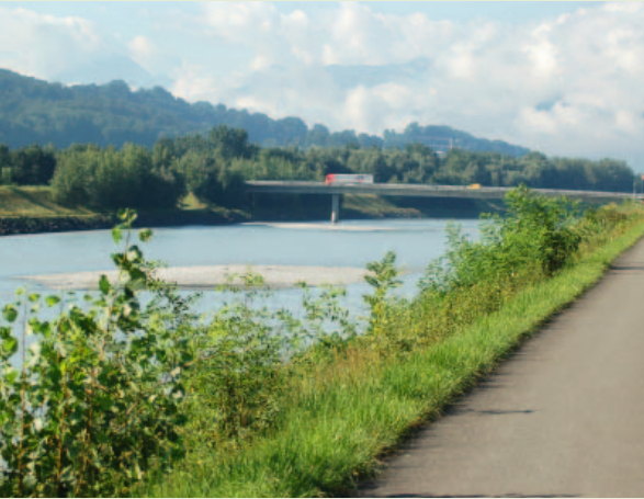
Blick vom Hochwasserdamm auf den Alpenrhein.
