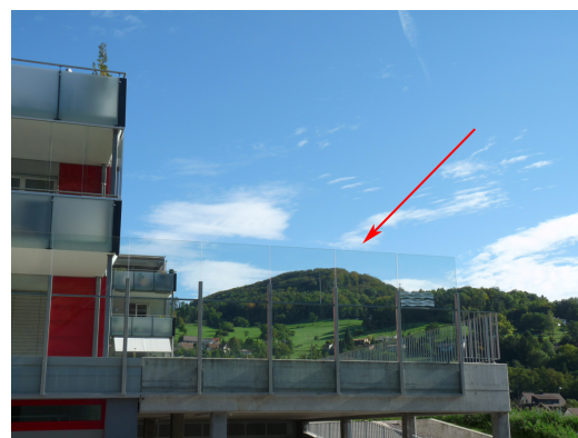
Surface en verre dans les endroits exposés (parois anti-bruit ou coupe-vent, passerelles, etc.)
