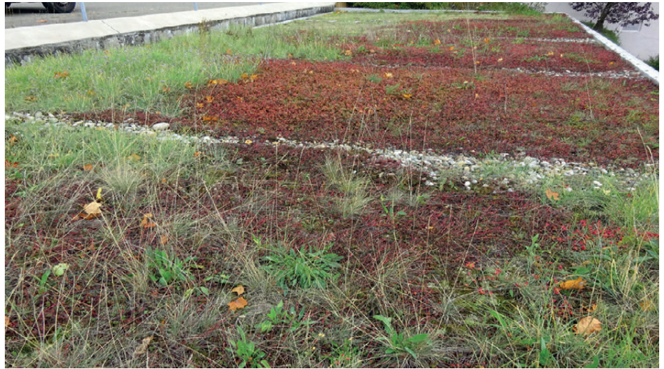
Mit verschiedenen dicken und unterschiedlichen Substraten kann eine abwechslungsreichere Vegetation erreicht werden.
