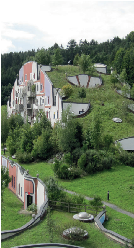
Begehbares Dach eines von Hundertwasser gestalteten Hotels.
