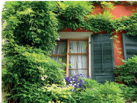
Kletterpflanzen schützen die Fassade vor der Witterung.
