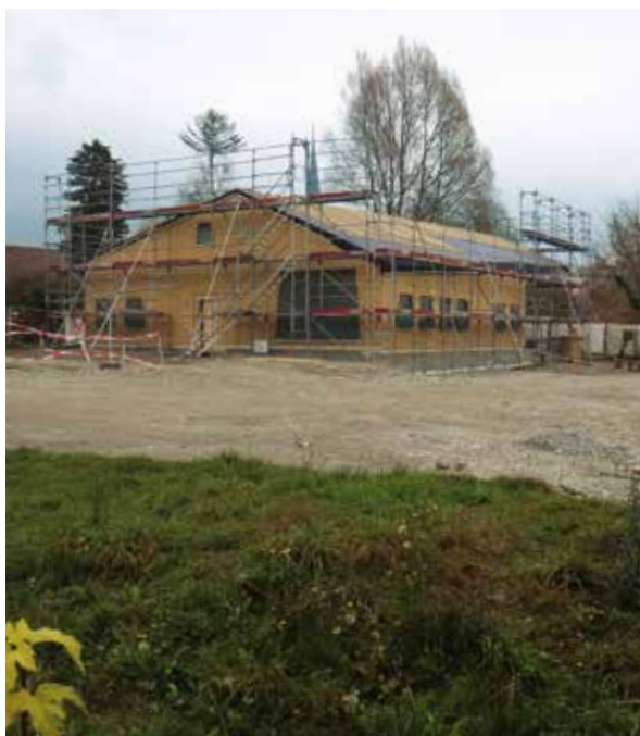
Das Naturzentrum Pfäffikersee im Bau.
