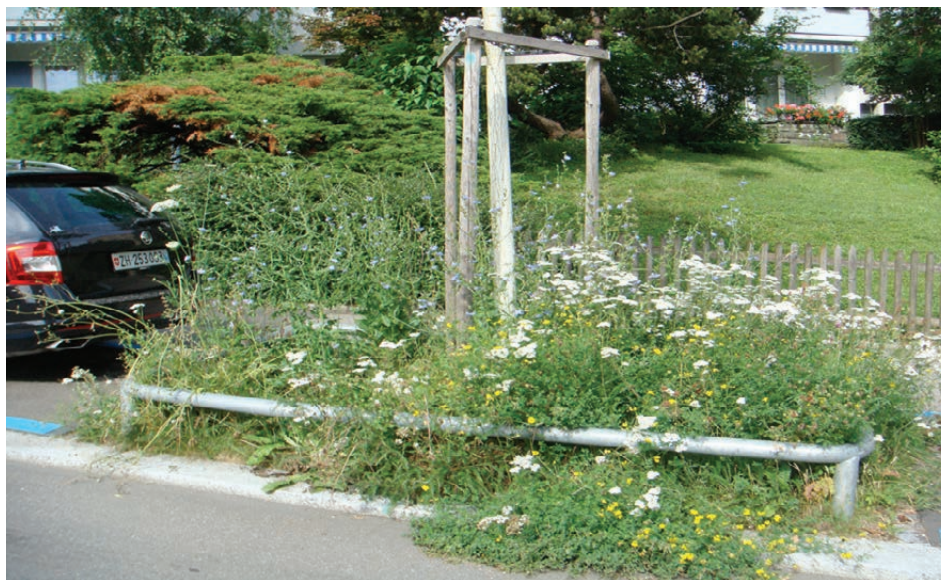
Protection efficace du pied de l'arbre et stabilisation du tronc par trois tuteurs.
