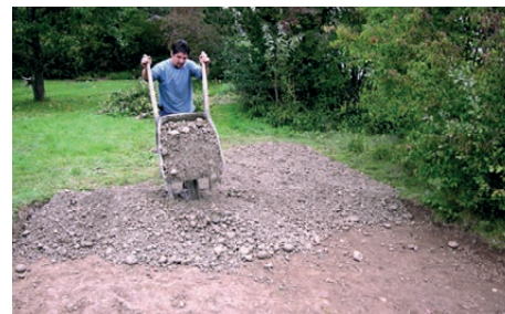
Mise en place d'une surface rudérale : la surface à planter est recouverte de tout-venant.
