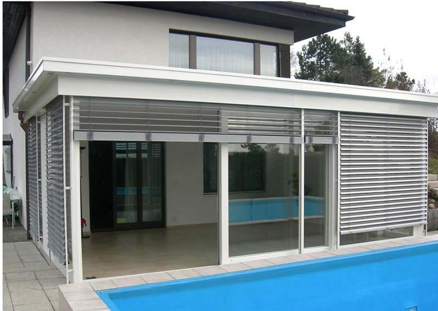
Aussen angebrachte Beschattungssysteme unterbrechen den spiegelnden Effekt, der sonst durch die glatte Glasfläche entstehen würde, oder markieren die transparenten Ecken.
